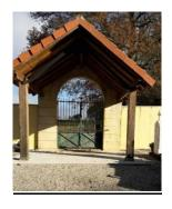
Une dalle béton a été réalisée sous le porche du cimetière pour faciliter l'entrée de ce dernier
